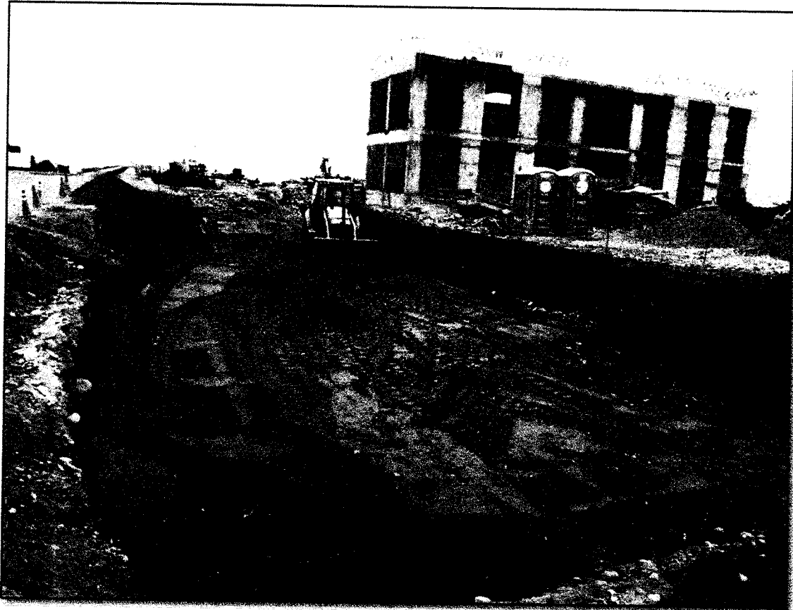
SUSTENTO FOTOGRAFICO – VALORIZACION N°02 DEL ADICIONAL N°02
